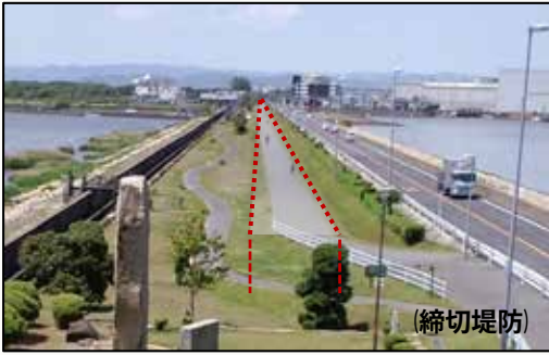
二重締切鋼矢板の設置計画ライン
