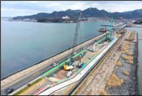
鋼矢板の施工状況（令和2年度）
