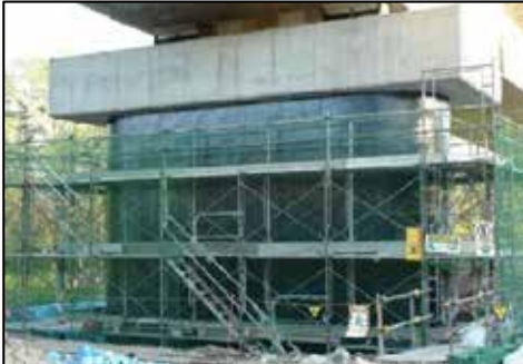
炭素繊維による橋脚の巻立て補強事例
