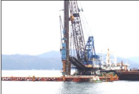
海上での杭の施工事例
